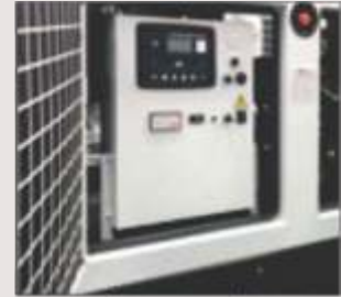
PANOU CU UNITATE DE CONTROL SUPLIMENTARA DE URGENȚĂ
