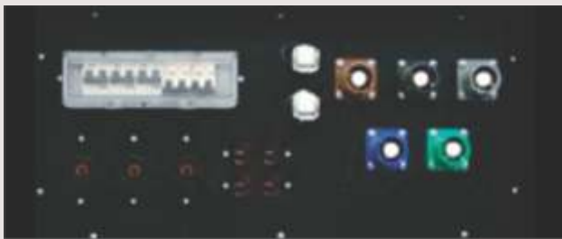
PANOU DE DISTRIBUȚIE CU CONECTOARE 250/400/650A
